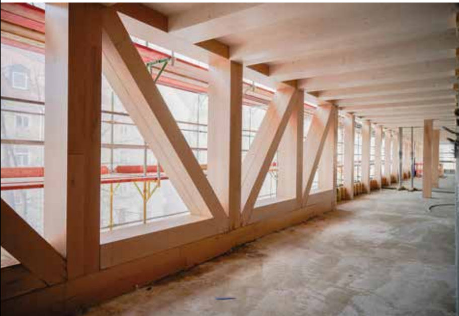
Konstruktion aus Baubuche.
